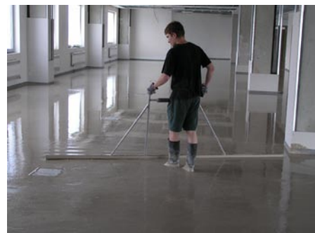
Nivelace a odvzdušňování tekutého potěru pomocí „rádla“.
